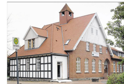
Wurde außen wie innen auf den Stand gebracht: Die ehemalige Grundschule Stemmer.
